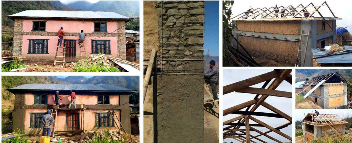
Les cases reforçades gairebé acabades, amb cantonades armades i diagonals de fusta afegides.
