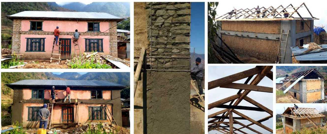
Les cases reforçades de Supin gairebé acabades, a falta d'executar totes les diagonals de fusta.
