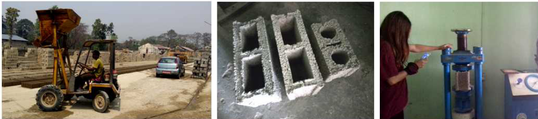
Fabricació dels "blocs Awasuka" i proves de resistència comparant entre blocs locals i blocs Awaskua.
