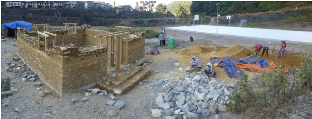
Prototipo de piedra y barro, futuro edificio de vestuarios y servicios para la pista polideportiva.
