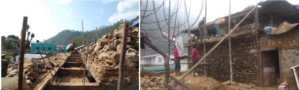
Prototipo de refuerzo, de piedra y barro. Vivienda reparada y reforzada de la familia Pradhan.
