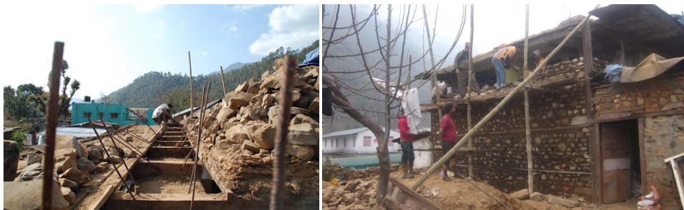
Prototip de reforç, de pedra i fang. Vivenda reparada i reforçada de la família Pradhan.
