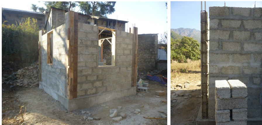
Prototip de bloc de formigó, vivenda mínima de Santamaia Didi, cuidadora de l'orfenat de Balmandir.
