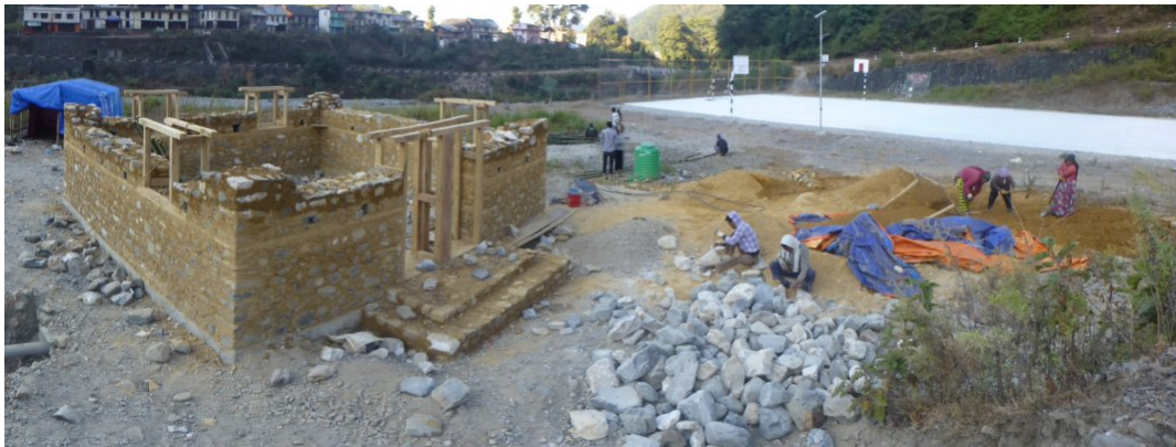
Prototip de pedra i fang, futur edifici de vestuaris i serveis per a la pista poliesportiva.
